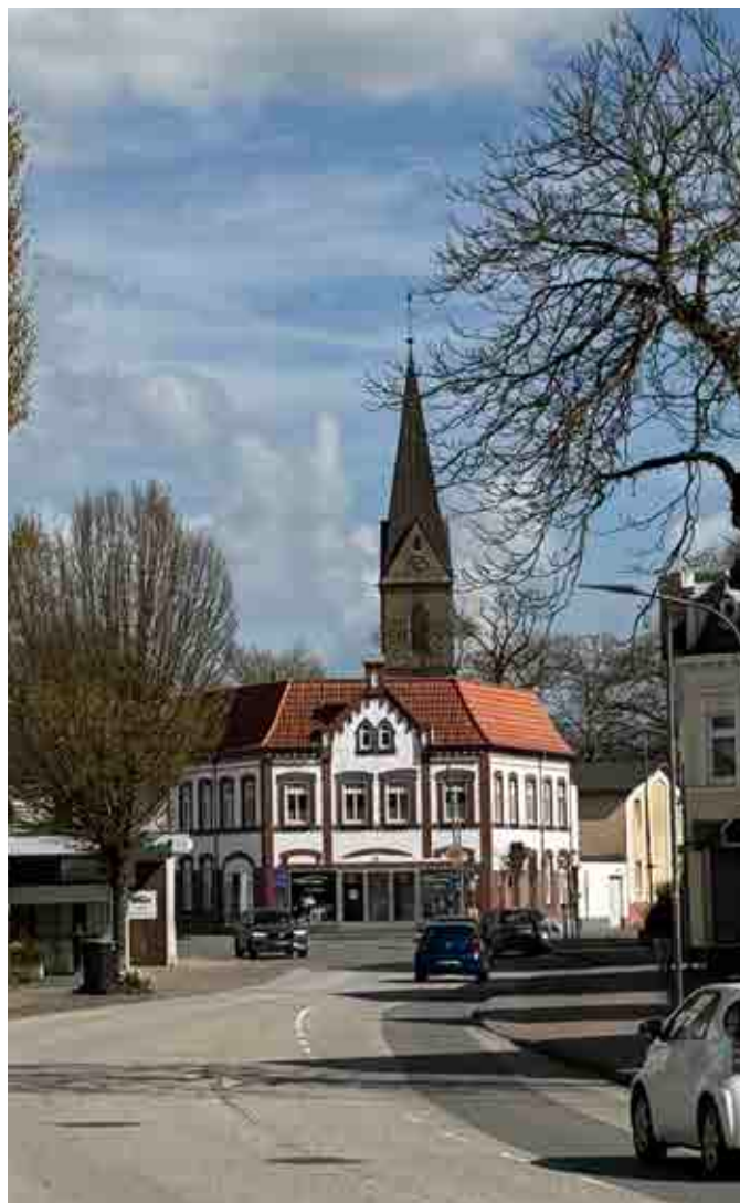
Ortsbildprägendes Gebäude Ecke Kappeler Straße/Teichstraße (Q: s+w plus)
