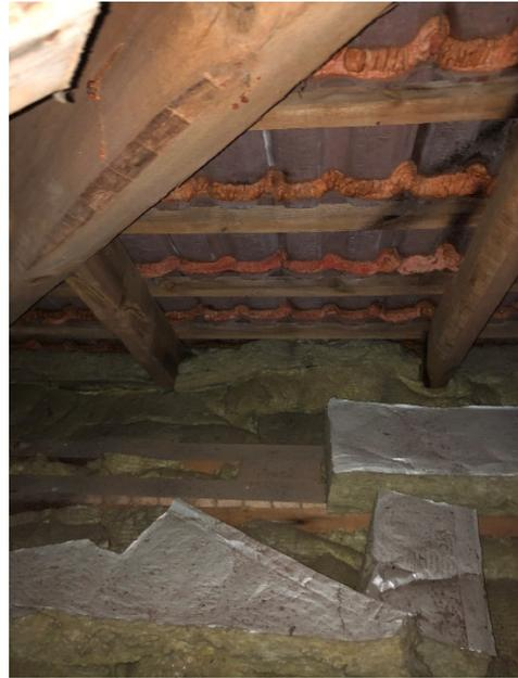
Abb. 27: Unregelmäßige Dämmung der OG
