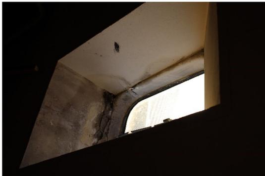
Abb. 26: Feuchtigkeitsschäden an den Dachfenstern
