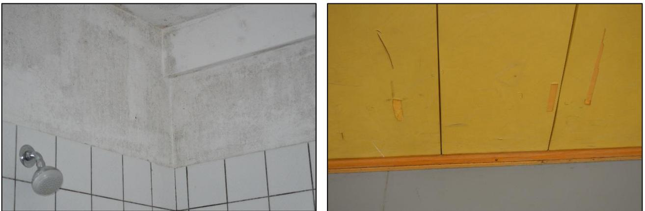
Abbildung 38: Sporthalle in Boren (links: Schimmelbefall in den Duschen; rechts: defekter Prallschutz)
