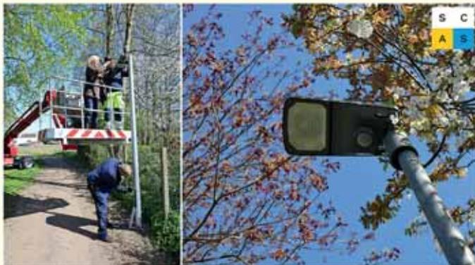
Die Installation von LED-Lampenköpfen mit optischen Sensoren im Tannenbergsweg ist erfolgreich abgeschlossen. Ziel ist es, die Beleuchtung und Sicherheit in diesem beliebten autofreien Weg zu verbessern. Zudem wurde die Anzahl der Lichtmasten erhöht.
