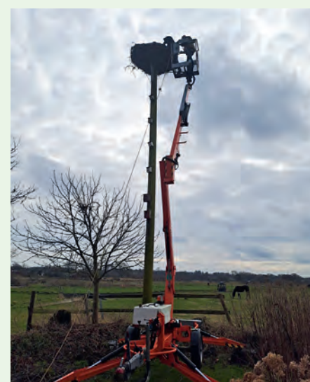
Renovierungsarbeiten in luftiger Höhe
