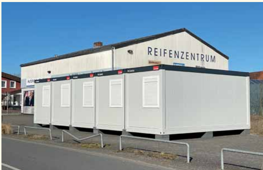
Diese Container der Interims-Rettungswache werden voraussichtlich ab 1. April in den Betrieb genommen
