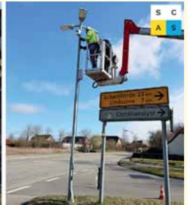
Auf dem Foto zu sehen sind Martin Sekandari der Firma Ebero Fab mit dem optischen Sensor, sowie Kristiane Stotz vom Smart City Team.
